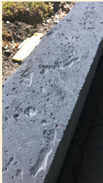
Lofbólugöt sem þarf að kítta í undir þéttiborða
