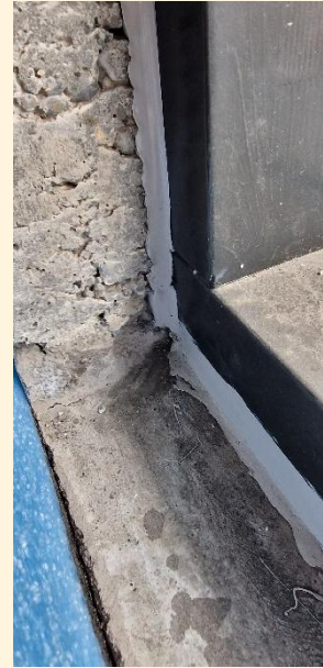
Búið að kítta yfir steypuhreiður
